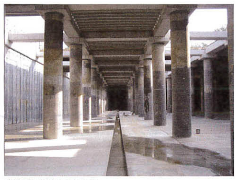
山王公園地下の貯水池
